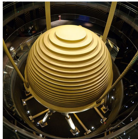
Abbildung B.1: Schwingungstilger im Gebäude des Taipei 101 (Quelle: www.wikipedia.org )
